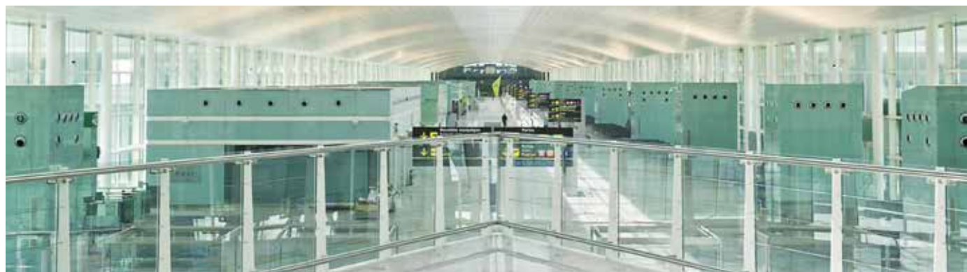
Aéroport de Barcelone, Terminal 1, Barcelone, Espagne Architecte : Ricardo Bofill Taller de Arquitectura Lamineur : Vitro Produit présenté : Saflex Acoustic
